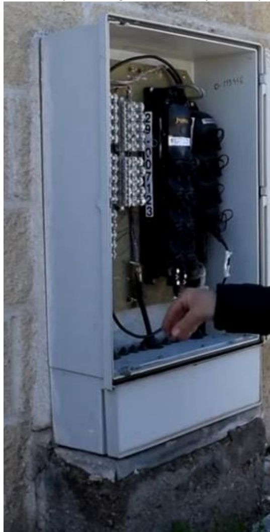
En las viviendas unifamiliares también se puede llegar con una Caja de Empalme en pedestal:
